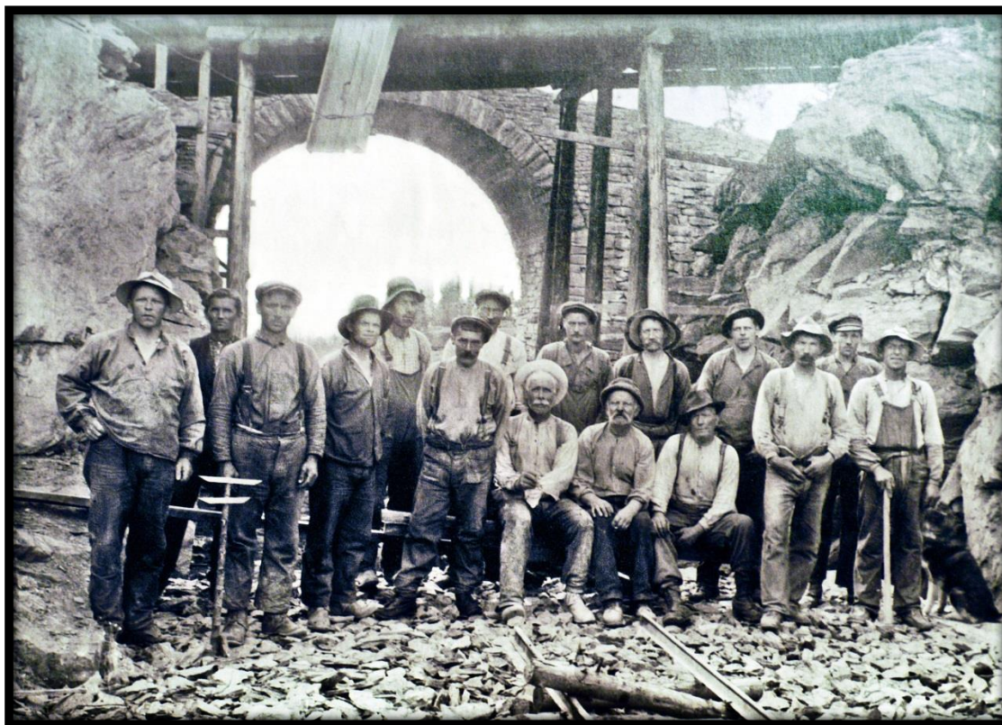
«Her bygges steinhvelvbrua over jernbanen i Lurudalen» (ca 1920) – fotograf ukjent.
