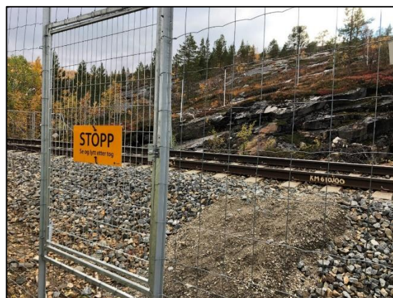
Figur 5 Eksempel på gangport for kryssing av banen ved ferister og inspeksjonsporter.
